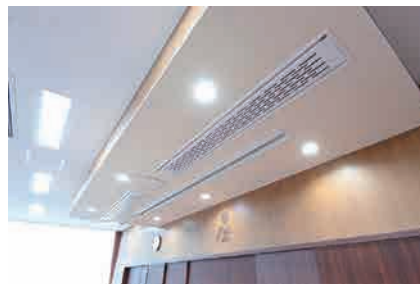
2階会議室の檜上に設置
