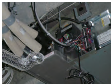
<高性能FCU側配管保温例>
