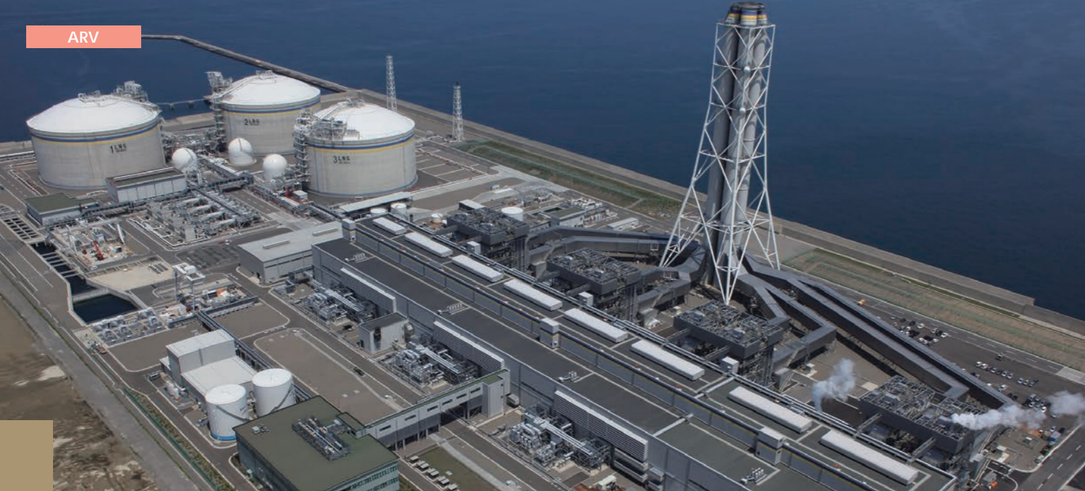
中部電力 上越火力発電所サービスビル様
