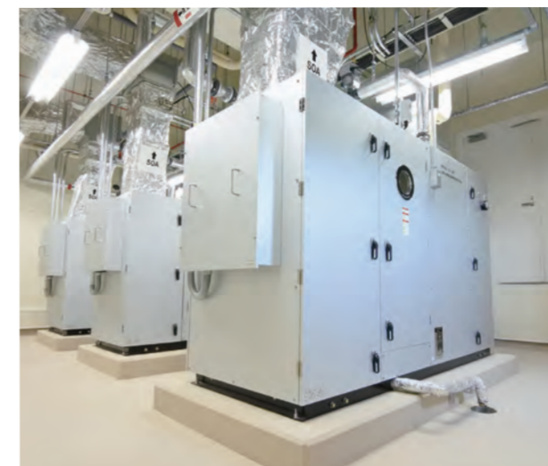
手術室系統 空冷直膨式外調機
