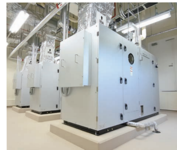
手術室系統 空冷直膨式外調機
