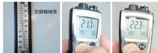
空調機械室入口前 21℃
