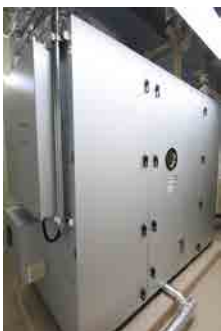
空冷直膨式エアハン（CAV型）
