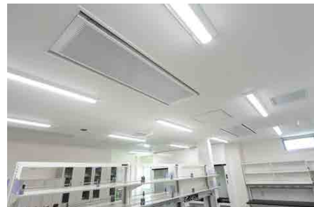
天井には標準形を、壁面にはスリム形を配置
