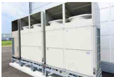
空冷直膨式室外機（防雪フード付き）
