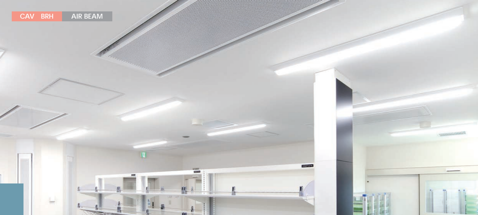
神戸天然物化学株式会社様 出雲第一工場品質管理棟
