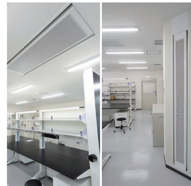
天井には標準形を、壁面にはスリム形を配置
