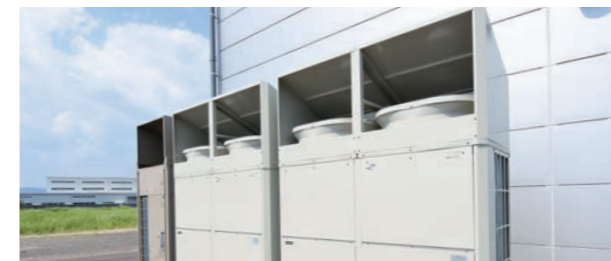
空冷直膨式室外機(防雪フード付き)
