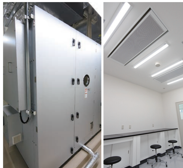
空冷直膨式エアハン(床置形 CAV型)
