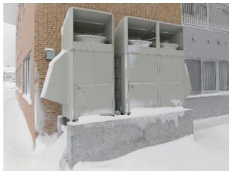
防雪フードは、降雪による熱交換器の目詰まりや風雨による着霜などを抑制し、暖房能力の低下を防ぎます。
