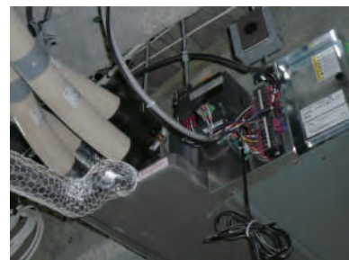
<高性能FCU側配管保温例>
