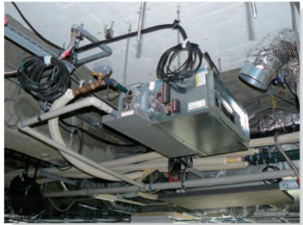
FCU(配管、PB管使用)
