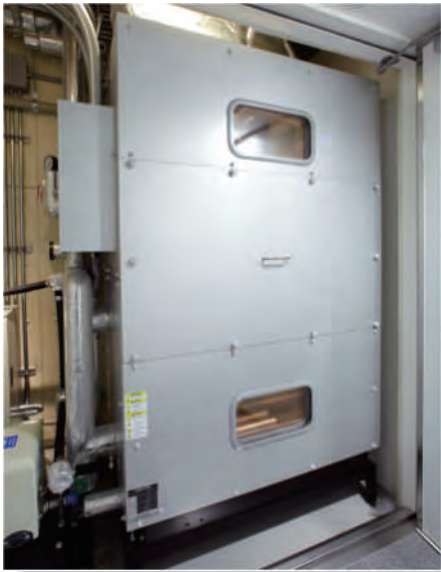
外気混合空調機(400m 2 用)
