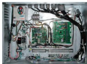
温湿度制御、CO2制御、外還気等換制御、外気冷房、外気冷房時の低温加湿制御、中間期加湿暖房、調光制御、制御「見える化」などの空調制御装置を機内に組み込みます。
