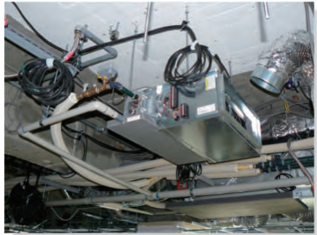
FCU(配管、PB管使用)
