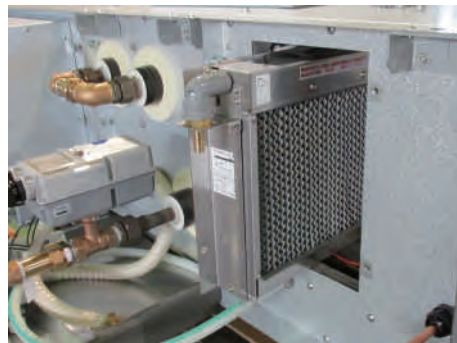
< ファンモータ、気化式加湿器 横引出し構造 >
