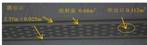
図3 パネルの写真及び寸法 注2
