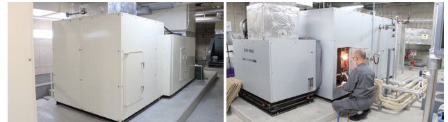
平成7年納入の冷温水式エアハン
