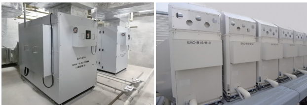
宴会場系統の外気混合空調機
