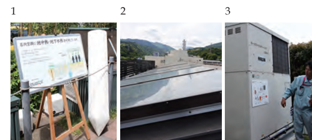
1. 地中熱用の熱交換パイプ 2. 太陽熱温水パネル 3. コージェネシステム
