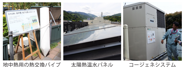
地中熱用の熱交換パイプ
