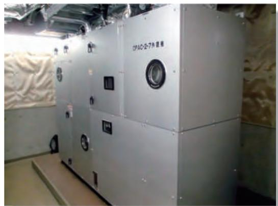
—屋外据付例 熱回収外調機(BSD型)—
