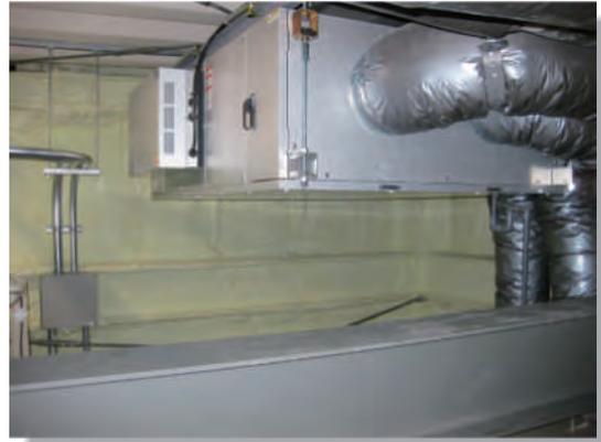
一機械室/屋外据付例 熱回収外調機(ARF型)一
