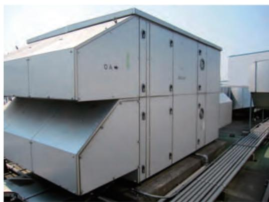
—屋外/機械室据付例 熱回収セントラル空調機(BWC型)—
