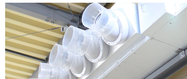
誘引パンカー 結露がなく冷風をより遠くへ
