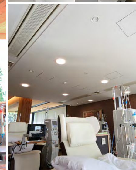
5.天井設備機器を同色ゾーンに集約しベッドを避けて配置 6.空冷直膨式エアハンで外気の温湿度を整え設備ゾーンから給気 7.2階北側は白を基調としたリクライニングチェアエリア
