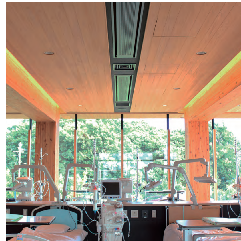
5.天井設備機器を同色ゾーンに集約しベッドを避けて配置 6.空冷直膨式エアハンで外気の温湿度を整え設備ゾーンから給気 7.2階北側は白を基調としたリクライニングチェアエリア
