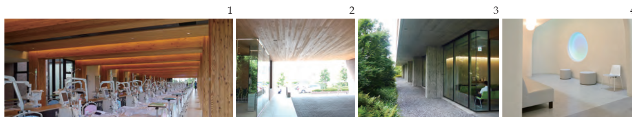
1.「燃エンウッド®」は中心部の荷重支持部(木)＋モルタル＋燃え代層(木)の構成により耐火1時間の認定 2.車寄せを兼ねたヒノキ板貼りのエントランス 3.外来待合スペースから植栽を臨む 4.アートフルな空間が1階送待合室から階段へ続く
