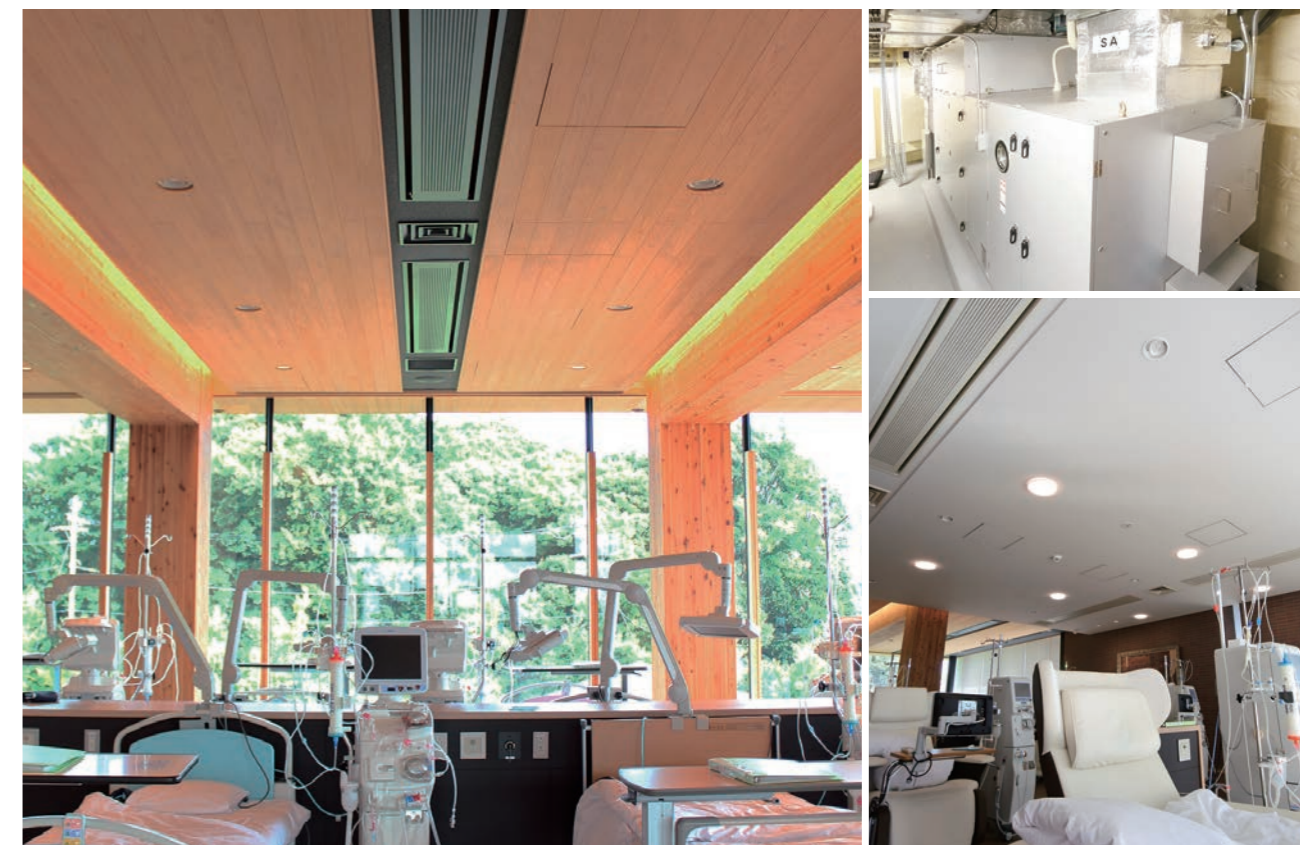
5.天井設備機器を同色ゾーンに集約しベッドを避けて配置 6.空冷直膨式エアハンで外気の温湿度を整え設備ゾーンから給気 7.2階北側は白を基調としたリクライニングチェアエリア
