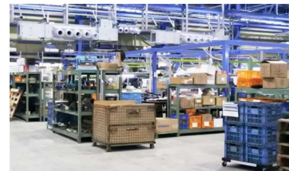
従業員の作業台が並ぶ広いエリアには、壁側に1台 (CRV2-5400HPSE)、手前に天吊形2台 (CRV2-6900HPSE) 設置。
