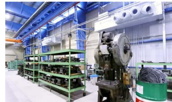
プレス機械など大型の機械が並ぶエリアには、壁側に2台 (CRV2-5400HPSE) 設置。
