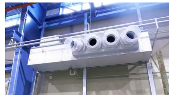
インバータを搭載しており、風量・吹出方向を自由に調整できます。
