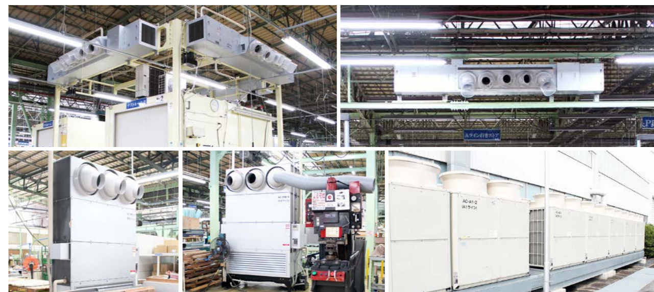
床置形は奥行480mmの薄型吹出し高さ約2300mm
