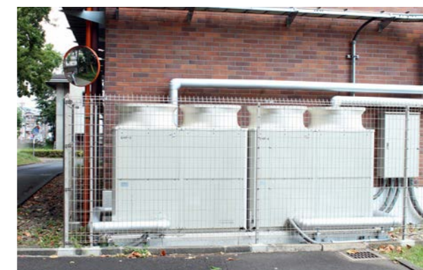
直膨式空冷室外機
