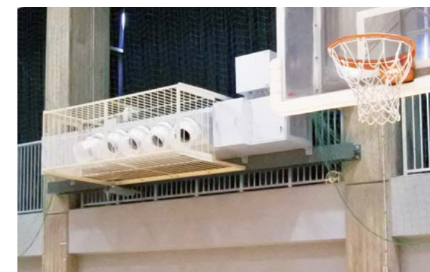
1階に4台設置し、人のいる範囲を広く空調 納入機種:CRV2-6900HP(改)
