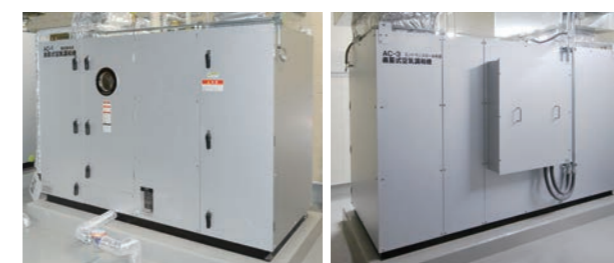
左：直会室系統 外気混合空調機(コンパクト形) 右：エントランスホール系統 外調機(コンパクト形)
