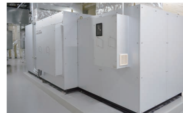
能楽堂系統 外気混合空調機
