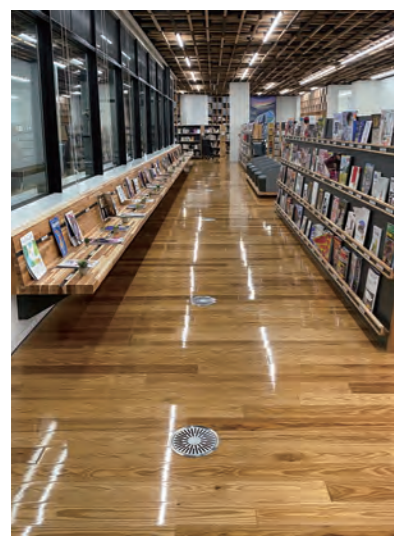
「エア・コンビ」で温湿度調整された空気を床から吹き出し、快適性を高めます
