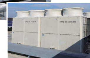
直膨式空冷室外機
