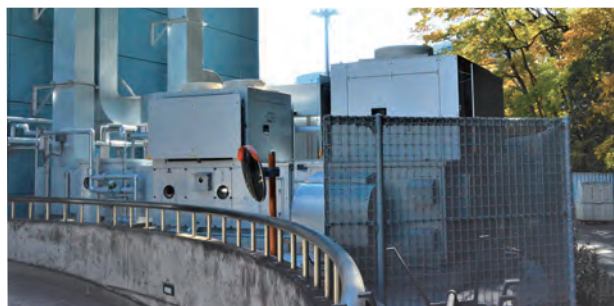
機器設置後(スロープ側より撮影)
