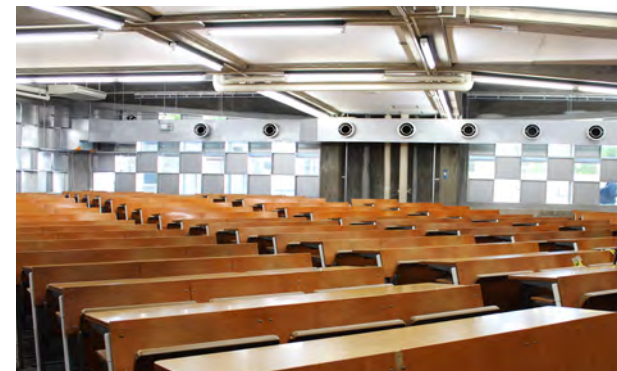
市松型の耐震補強材が印象的な大教室内に外気用ダクトを新設
