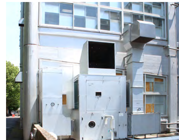
排気熱の影響を抑えるためフードを設置
