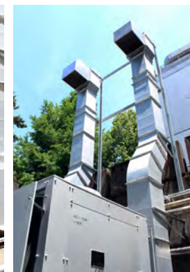
外気吸込みダクトを延長して施工
