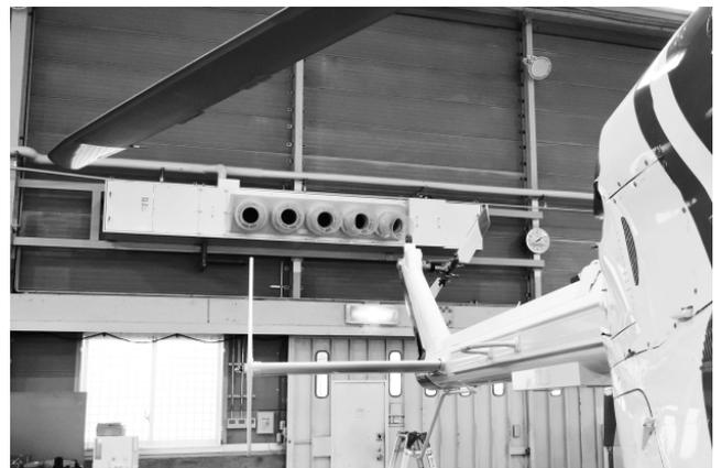
図1 工場用ゾーン空調機 壁面設置
