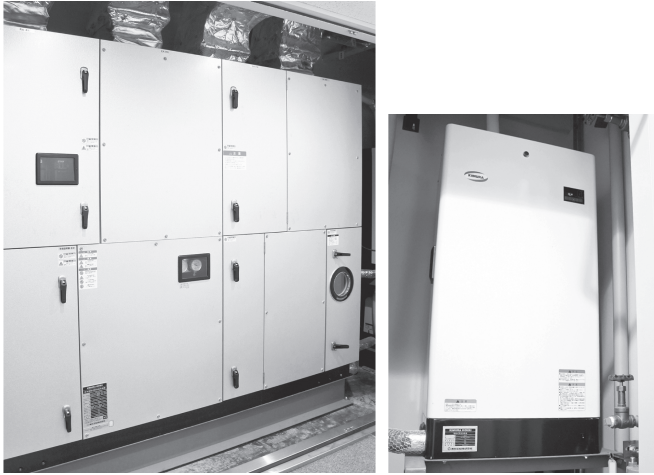
写真1 熱回収外調機ARV-YZ型（本体と蒸気加湿器）
