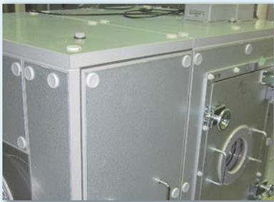
機内低温5℃に対応した専用の断熱ケーシングで屋外設置環境においても、熱損失や結露を低減し、衛生的環境の確保に繋がります。
