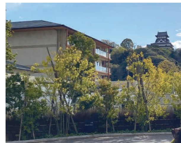
植栽で囲い目立たないように設置された空調設備
