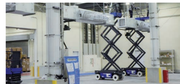
当社手配で施工を実施
