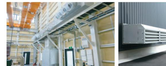
屋外吸込フードから新鮮空気を取り込み工場内に送り込むCRS2型
