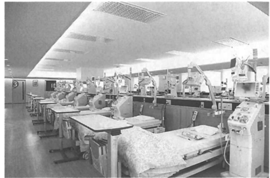
写真-1 病院採用例 (上：ごきそ腎クリニック，下：小豆島中央病院)
