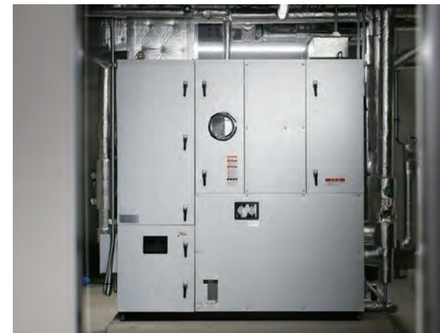
地下水を外気処理に活用できる水冷HP式外調機 WHP-CN-OA型
