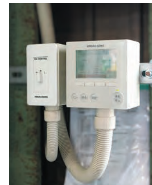
当社施工のCRV2-HPDX-H型(左)と空調制御スイッチ(右)
