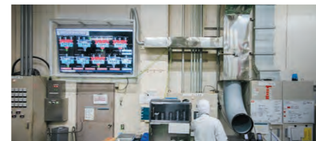
作業域だけでなくモニターの冷却にも活用されている新鮮外気
