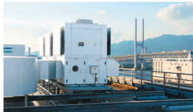
第二工場の屋上から東神戸大橋を望むRFT-OA型
