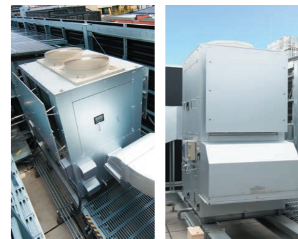
脱衣所に給気するAFN-RFT-OA型(左)と厨房系統のRFT-OA型(右)
