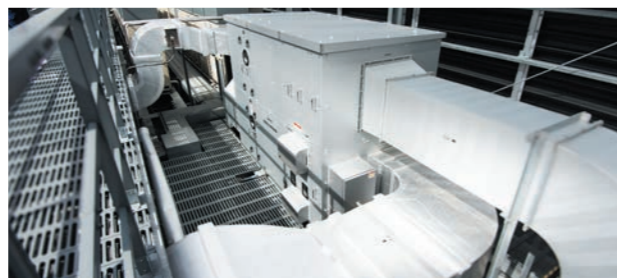
騒音にも配慮し採用された省スペース設置が可能なBSD-AD型
