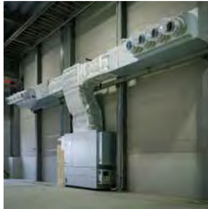
空冷直膨式/冷温水式工場用陽圧外調機 (外気導入、除湿、陽圧化、製品サビ防止)
