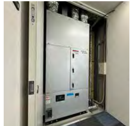
空冷HP式熱回収外調機、蒸気加湿器付 (冷暖フリーや単独運転も可)
