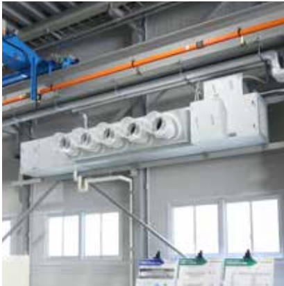
空冷直膨式/冷温水式工場用ゾーン空調機 (有効風量到達、標準20m以上)
