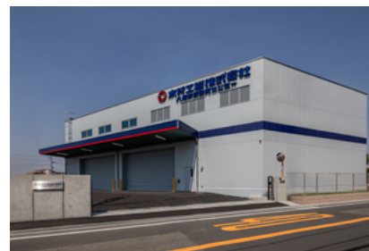
八尾技術研究センター外観
